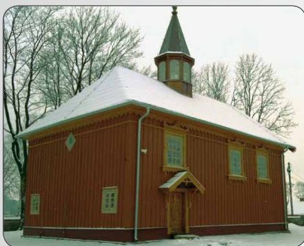
Fot. ks. Damian Misiar
